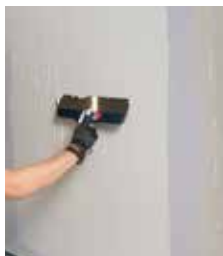
Bredspackling på vägg före tapetsering.
