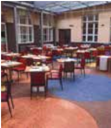
På nygjuten betong i exempelvis hotell.
