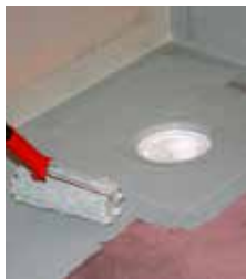
Tätskikt massiva konstruktioner.
