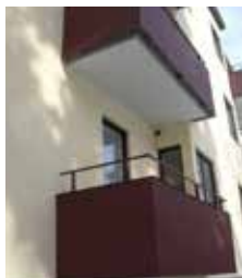
Lagning av balkonger.
